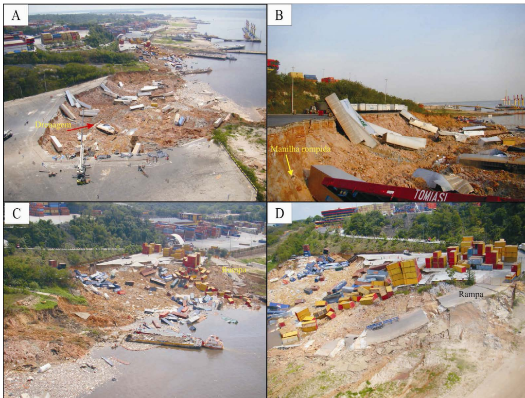
Figura 2- Fotografias das áreas afetadas pelo deslizamento. A) Vista aérea do pátio ATR, mostrando o arco de ruptura e a drenagem no eixo do arco; B) Detalhe da escarpa com manilha rompida em aterro; C) Vista da área do acidente do pátio alfandegado; D) Detalhe do pátio alfandegado com a rampa afetada pelo deslizamento.
