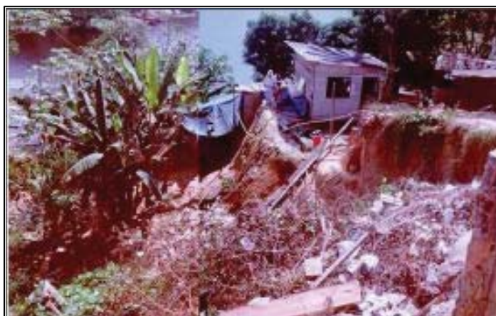
FIGURA 1 – Casa reconstruída após ser parcialmente destruída pelo avanço da erosão, observa-se o retaludamento da encosta, além da plantação de bananeiras
