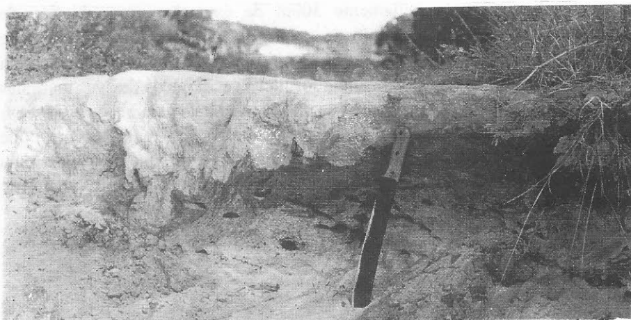
Figura 21 - Evidência do aterramento realizado no campo de dunas para o arreamento dos loteamentos.
