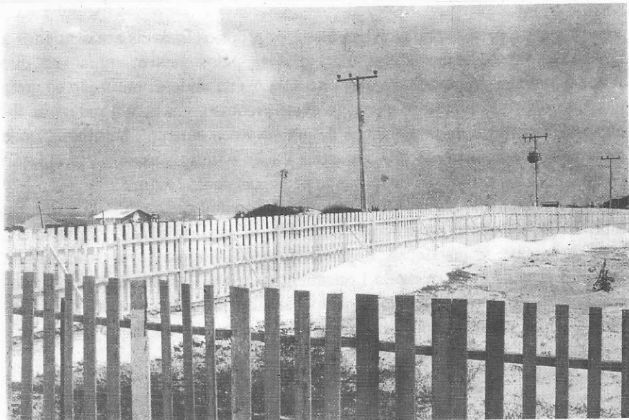
Figura 20 - Formação de pequenas dunas devido a construção de uma cerca que funciona como um obstáculo ao transporte de areia pela ação eólica.
