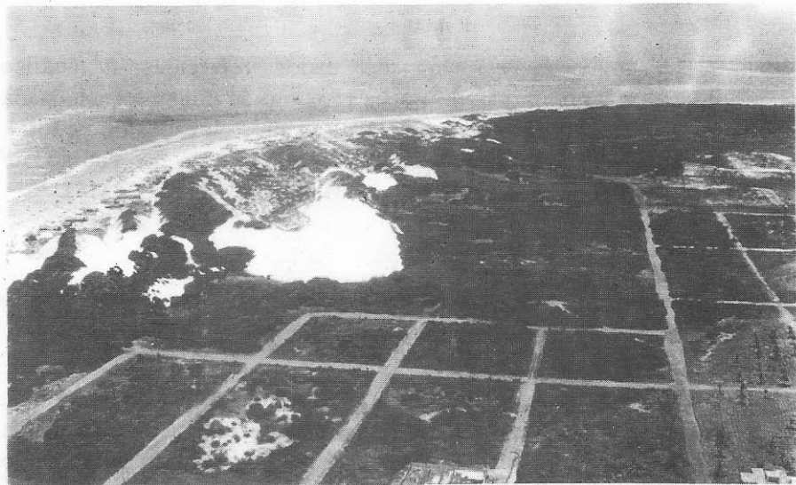
Figura 24 - Vista aérea mostrando as vias de acesso do loteamento Atalaia II e, ao fundo, com início no lado direito da foto, a estrada de acesso ao sistema de lagos e dunas.
