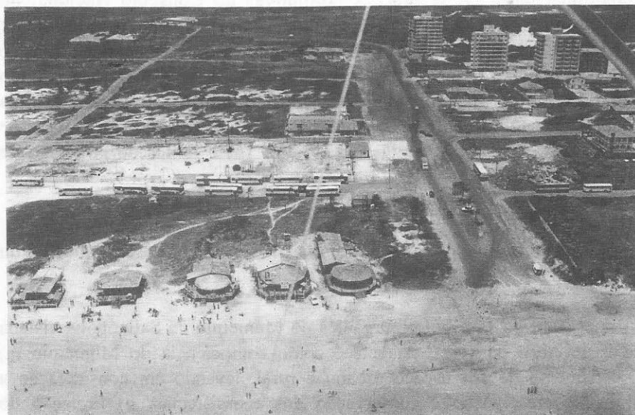
Figura 17 - Vista aérea do trecho final da estrada Salinópolis-Atalaia, construída sobre área de migração de dunas.
