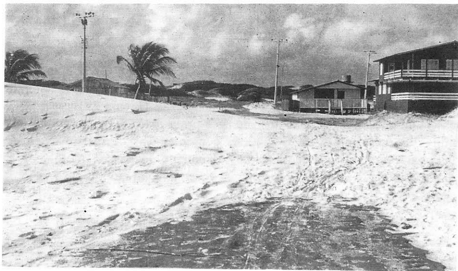
Figura 26 - Detalhe da acumulação de areias sobre a via de acesso à praia do Atalaia, construída irregularmente em área de migração de dunas.
