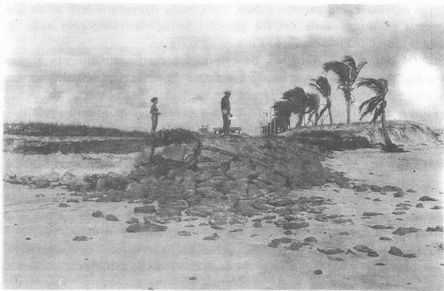
Figura 25 - Ataque frontal de ondas responsável pela destruição da via de acesso à extremidade leste da praia do Atalaia.
