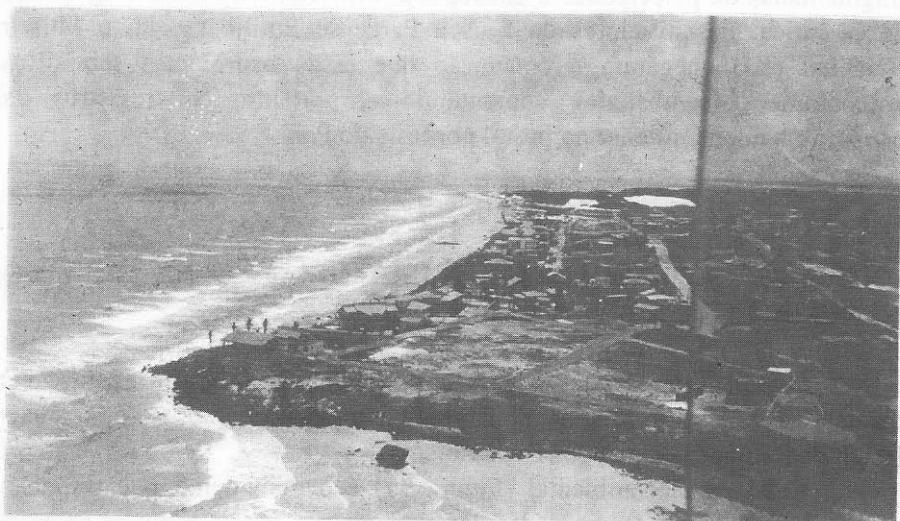
Figura 29 - Efeito erosivo de ondas e marés na residências construídas à beira-mar (praia do Farol Velho).
